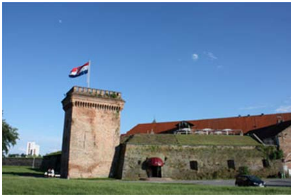
Die alte Ringmauer der früheren Festung steht zur Flussseite auch noch.
